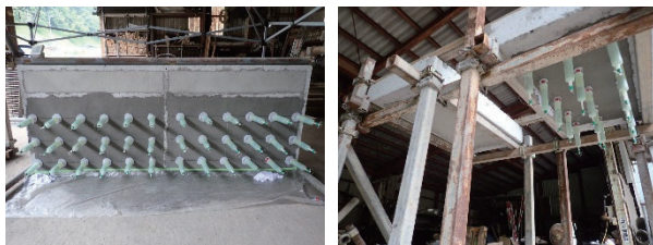
b) 樹脂注入状況
