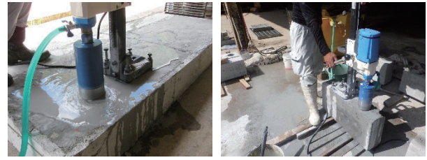
a) コア抜き状況
