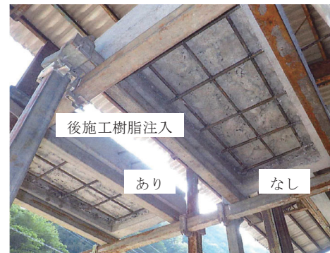
図-2 上向き施工用の既設躯体
