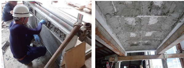
a) PCM 施工状況
